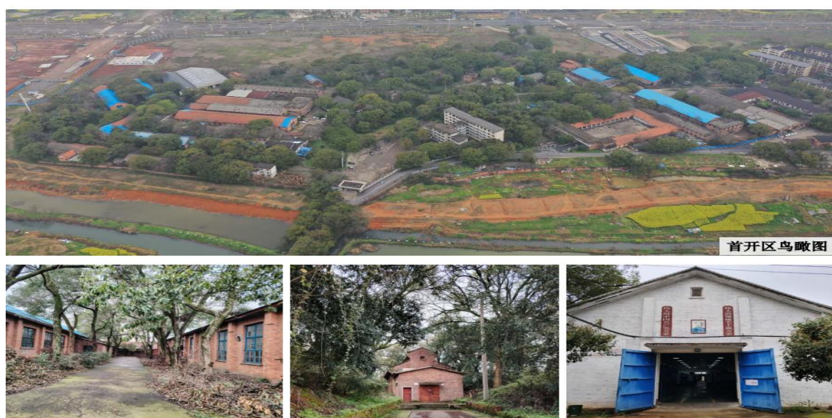
衡器产业园首开区改造前现状图
