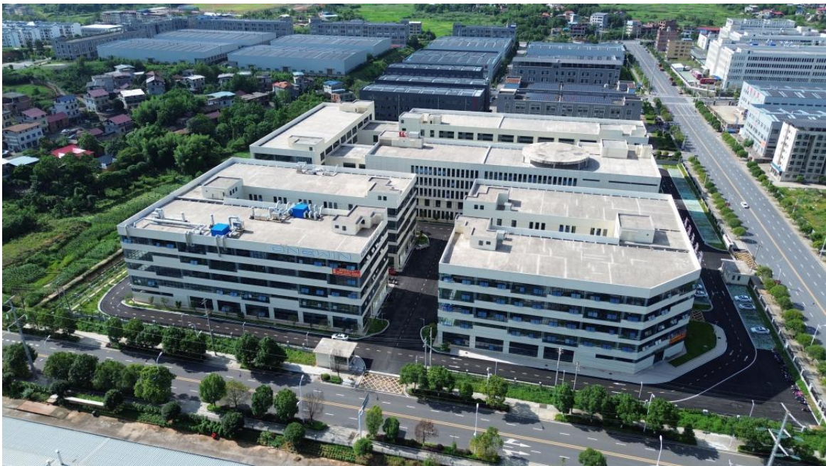
图 3 东安吉他产业园二期建设后现状照片
