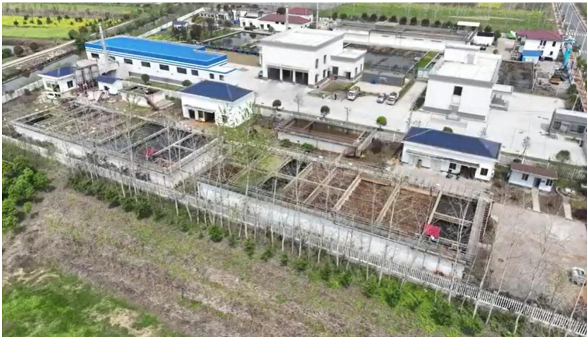
大通湖产业园区生物质集中供热项目现状图
