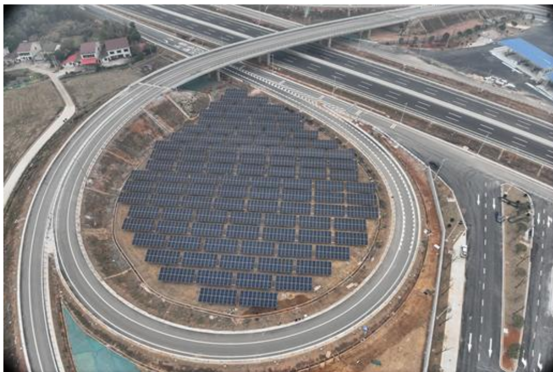
图 2 资阳区建立湖南首座互通光伏就近消纳电站
