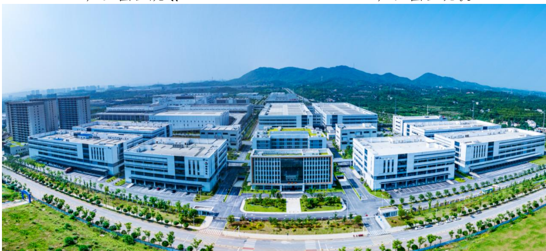
5G 产业园区全貌
