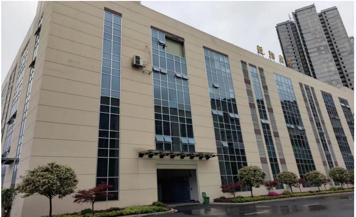
图 2 低效用地再开发项目建设完成阶段现状照片
