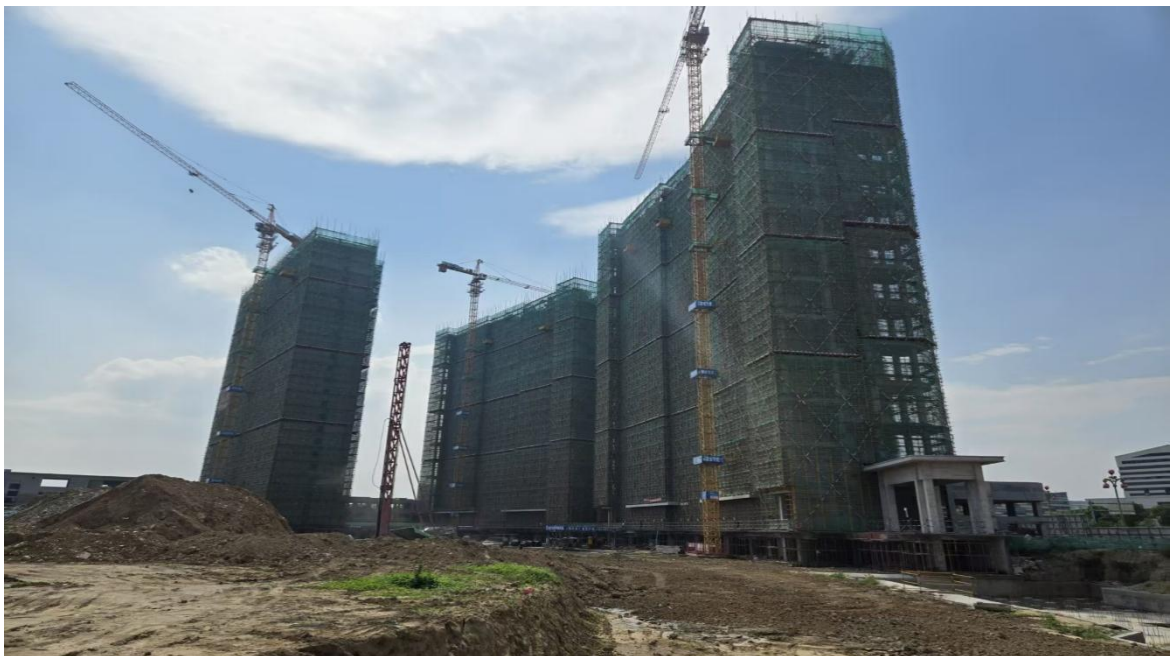
图 2 项目施工现场
