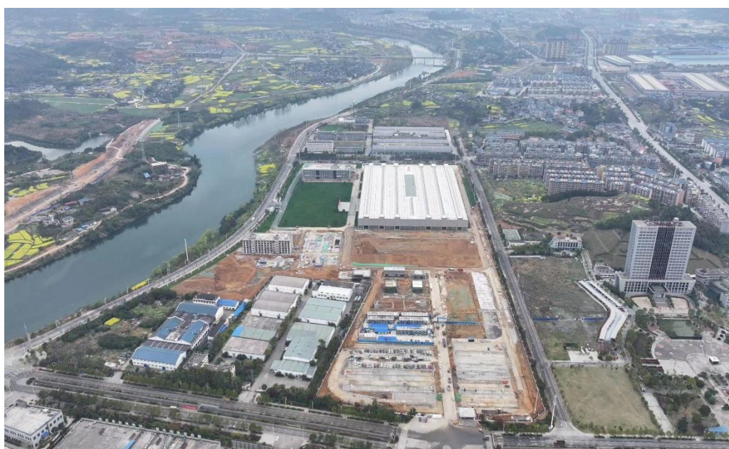
图2三一环境产业项目建设航拍图
